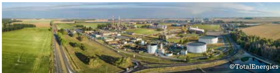
Photo montage de la future plateforme de Grandpuits
