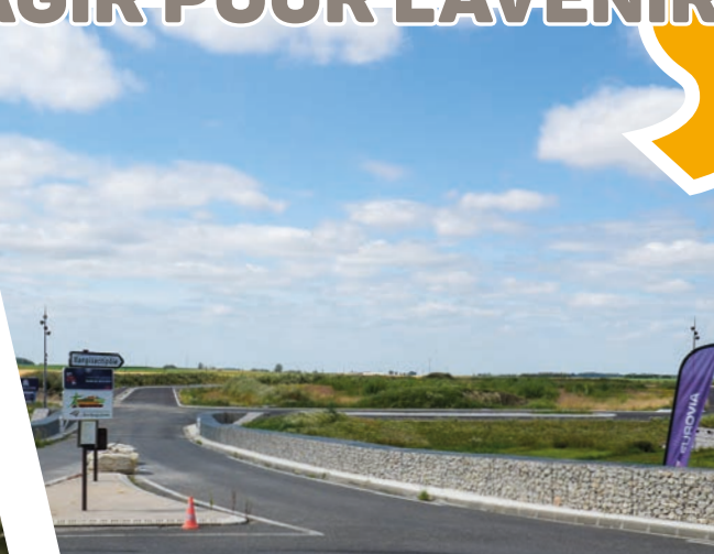
Travaux de la Z.A.C. Nangisactipôle
